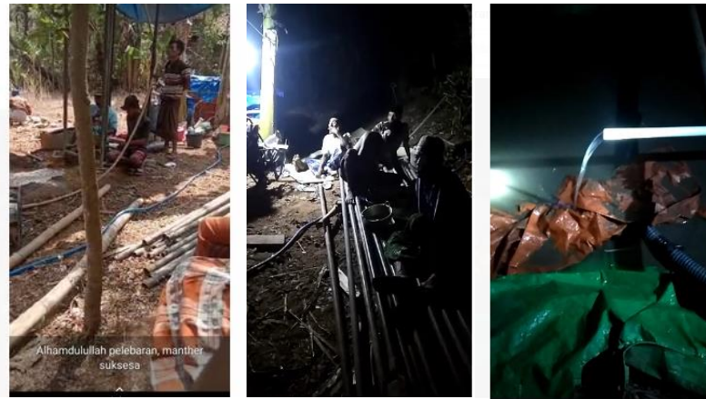
Gambar 3. Pembuatan Sumur Bor
