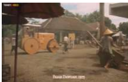
Gambar 6. Pembangunan Jalan di Pasar Dawuan (SP Menit 99.33).
