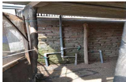
Gambar 5. Dari Digester disalurkan langsung melalui pipa
