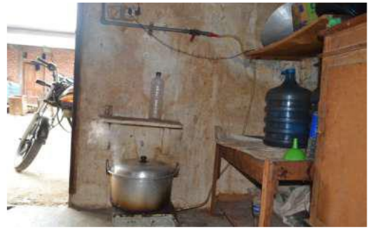
Gambar 8. Instalasi ke Kompor
