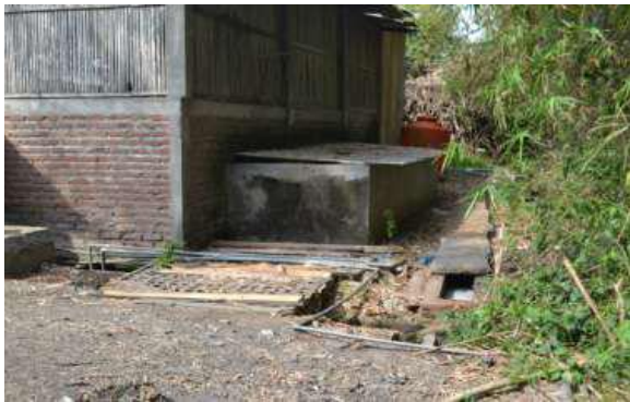
Gambar 3. Limbah dialirkan ke Bak Penampung
