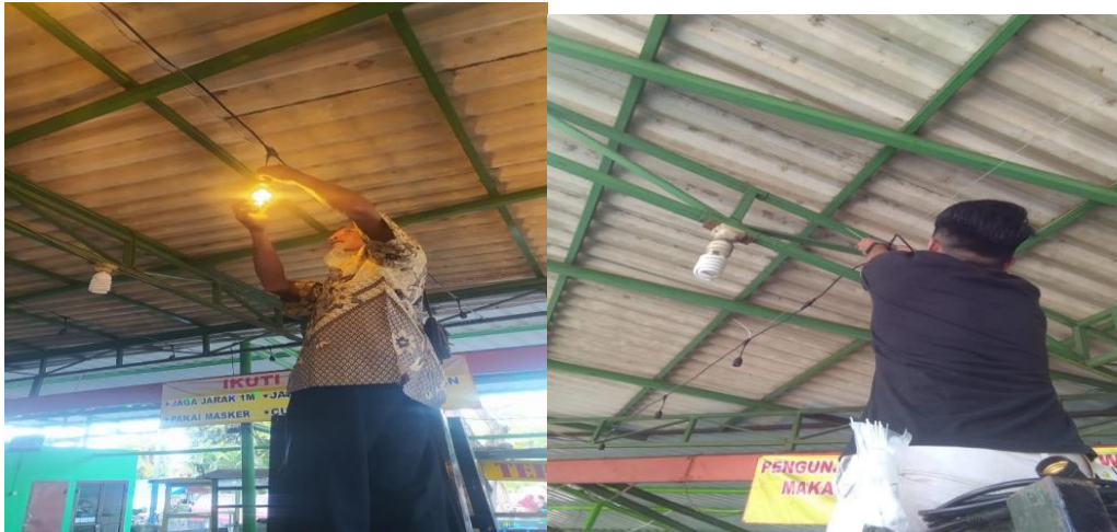
Gambar 5. Proses Pemasangan Lampu Hias
