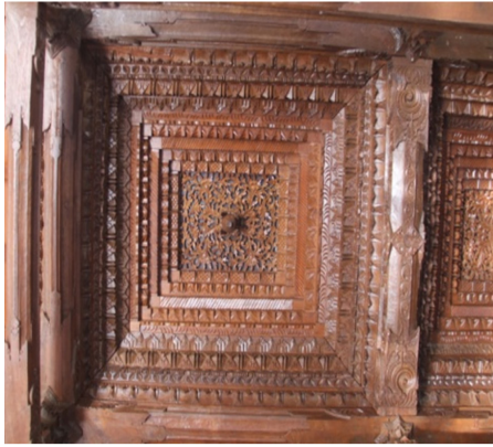
Gambar 4: Bubungan tumpang sari pada bangunan limasan menggunakan motif tradisional gaya Surakarta – campuran. Lokasi: Rumah KRT. Soekarno Putronagoro – Solo, 29 Maret 2021.
