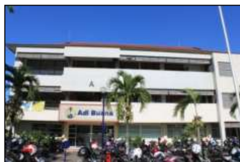
Gambar 2. Gedung Rektorat Kampus A
