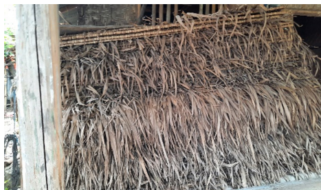
Gambar 4. Daun Tebu Kering Material Atap Rumah Tinggal Kampung Adat Keputihan (Sumber: Dokumentasi Nia Emilda, dkk., 2024)
