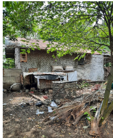
Gambar 10. Tampak Samping Rumah Tinggal yang masih menggunakan dinding geribik atau bilik dari anyaman Bambu (Sumber: Dokumentasi Penelitian Nia Emilda, dkk., 2024)
