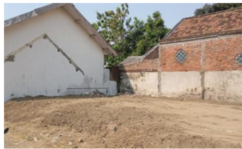
Lahan setelah disiapkan
