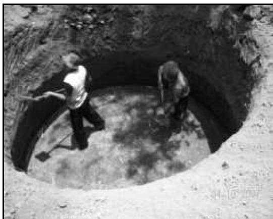
Gambar 3: pembuatan digester biogas
