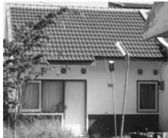
Gambar 1. Tampak Depan Rumah
