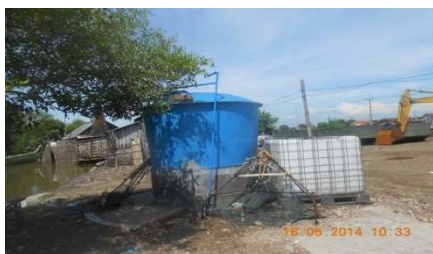
Gambar 7 Bak Penampung Air
