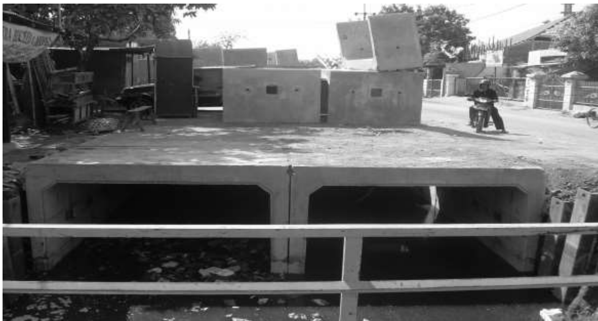
Gamba3. – Pemasangan Bangunan Box Culvert
